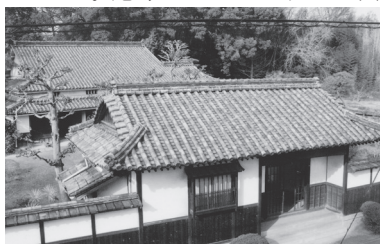
なくなる前の庄屋尾崎家の風格ある遺構＝倉敷市加須山(尾崎春三さん提供)
